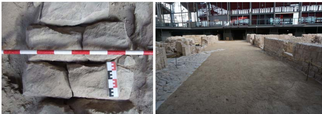
Fig.18 Detall de la coberta de claveguera UE 7994 abans de la intervenció i l'estat actual del carrer.
