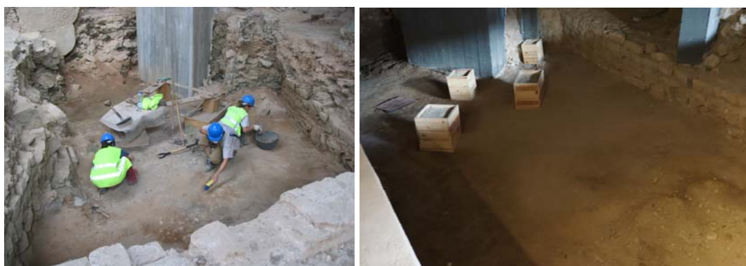
Fig.25 Detall de la intervenció i estat actual.
