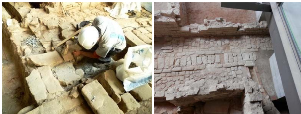
Fig.8 Detall de l'extracció del llot bentonític a l'esquerra i vista final del punt a la dreta.
