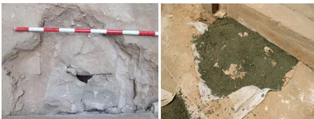
Fig.19 Detall de la coberta UE 70600 abans de la intervenció a l'esquerra i un cop coberta la dreta.
