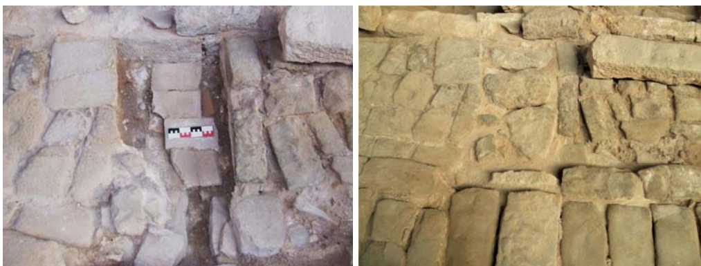
Fig.6 Detall de la coberta UE 20158 a l'esquerra i el punt finalitzat a la dreta.
