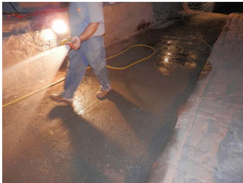
Realització de nous paviments
