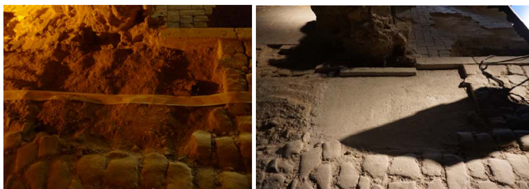
Fig.15 Detall del punt núm.15 abans i després de l'actuació.
